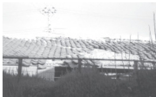
屋根瓦1/3落下、家屋半壊
